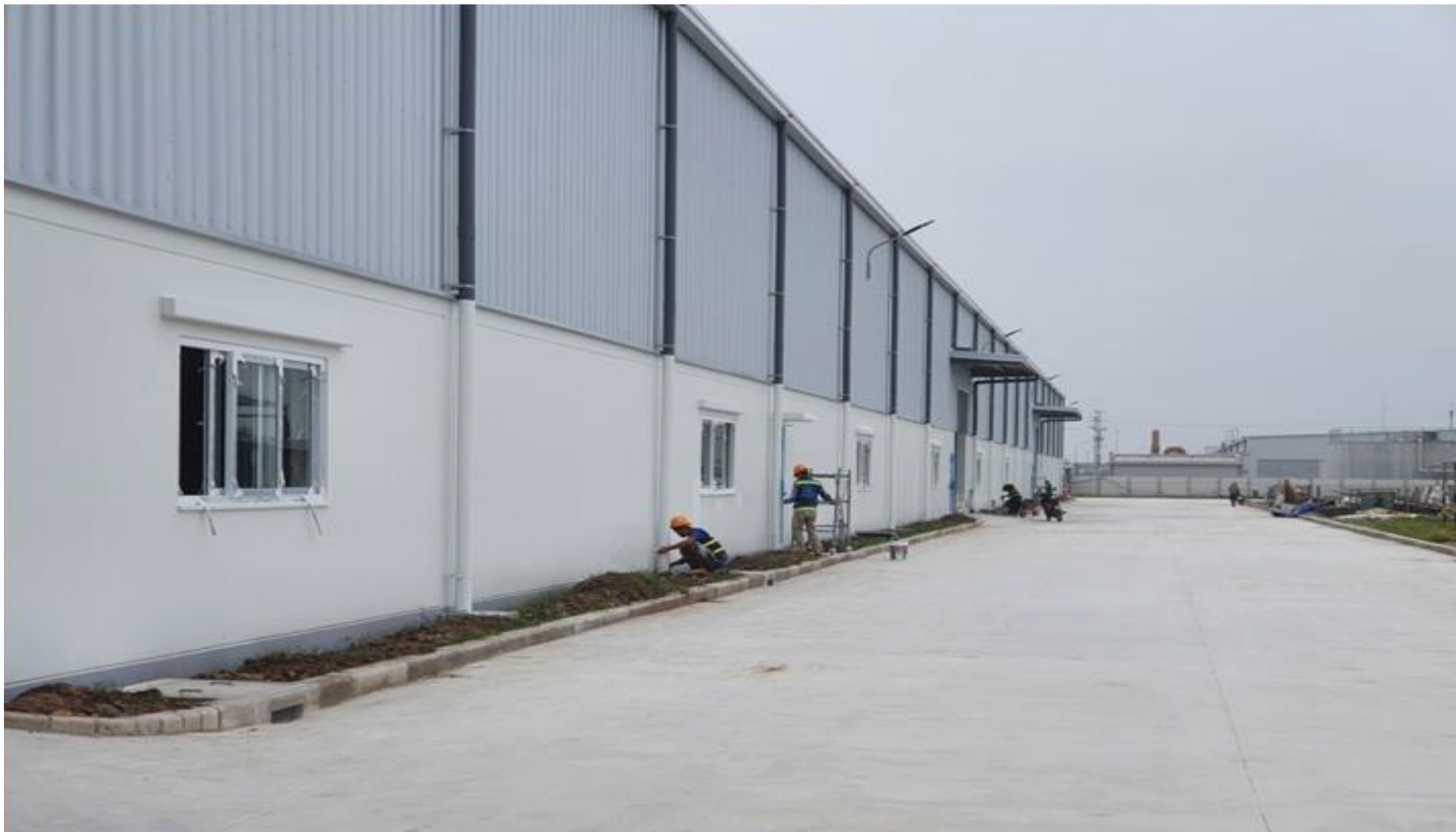
工場北面外壁塗装仕上げ
