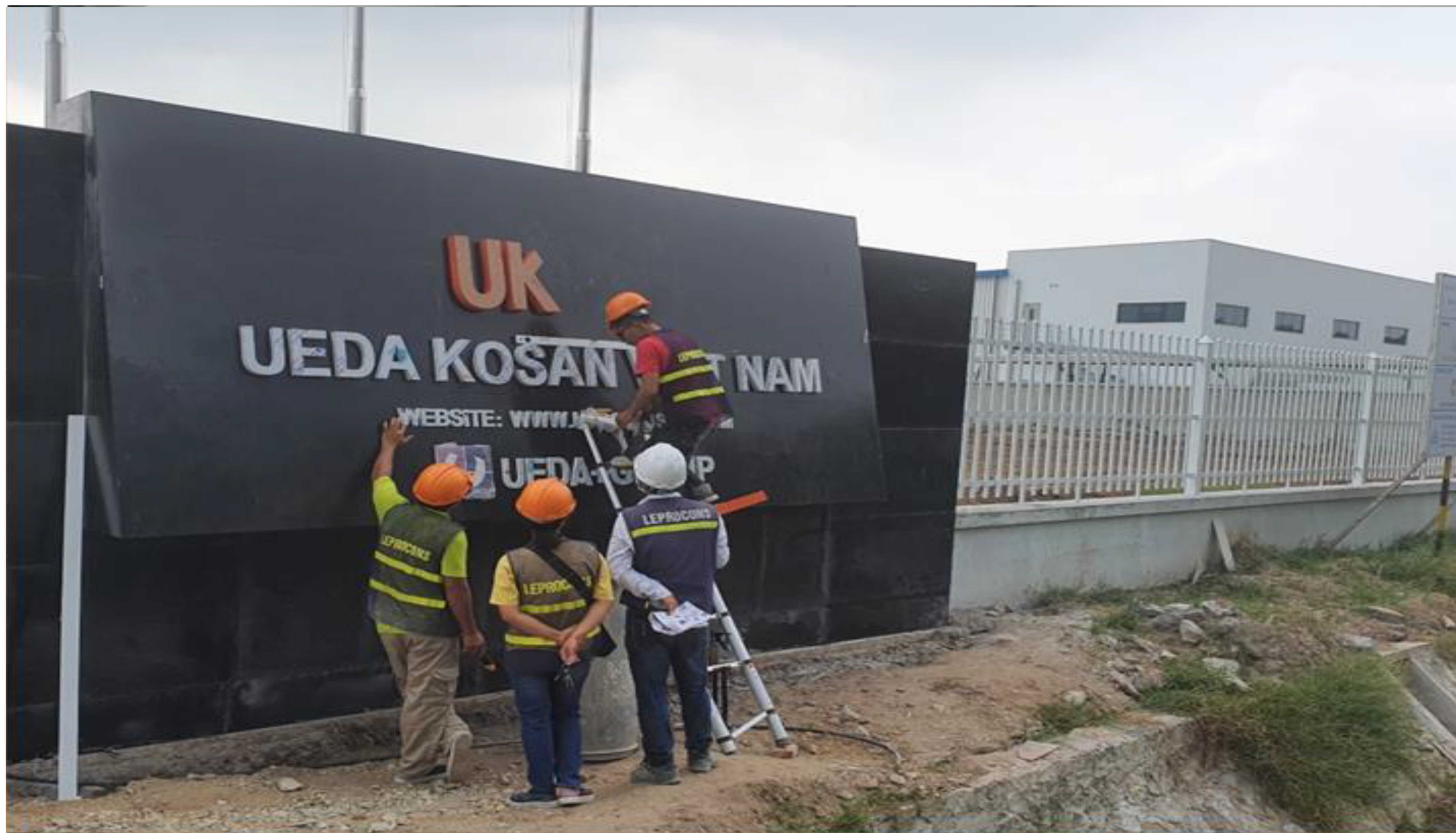
ロードサイド看板文字設置工事
