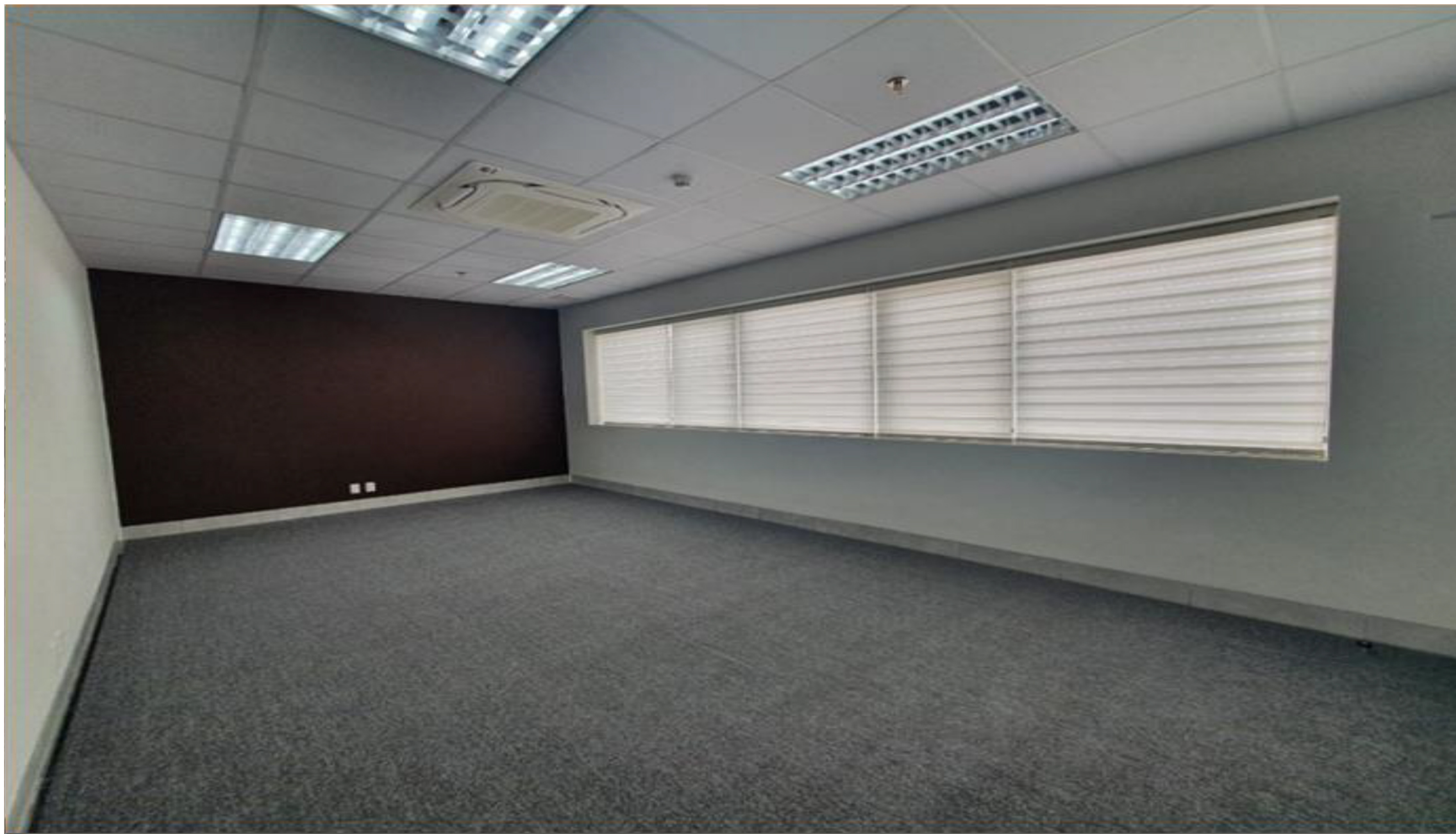
カーペット敷き込みアクセント壁、ブラインド設置完了（会長室）
